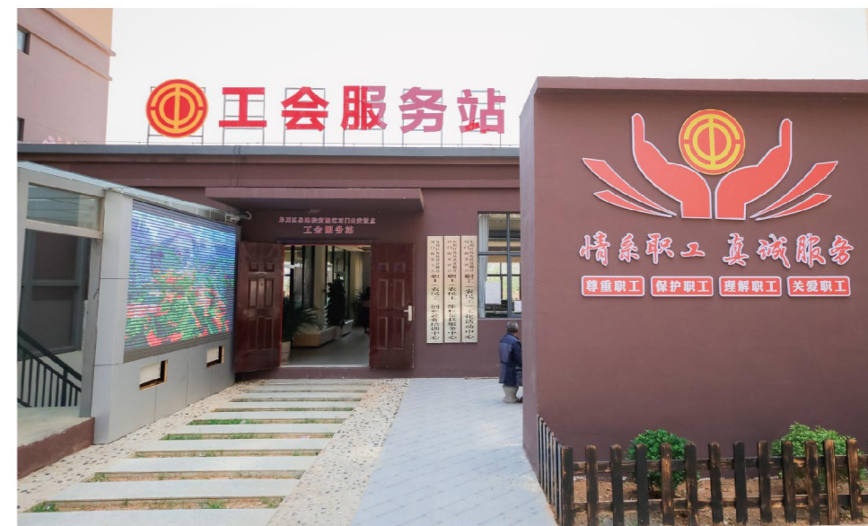
对门山安置点新建投入使用工会服务站
