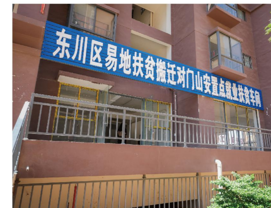
对门山安置点内正在建设的扶贫车间
